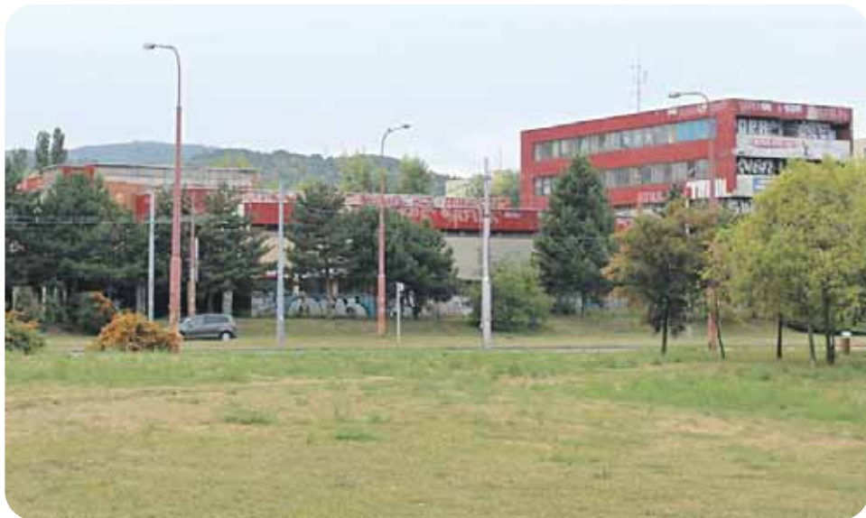
Ruina starej pošty na Saratovskej ulici.
