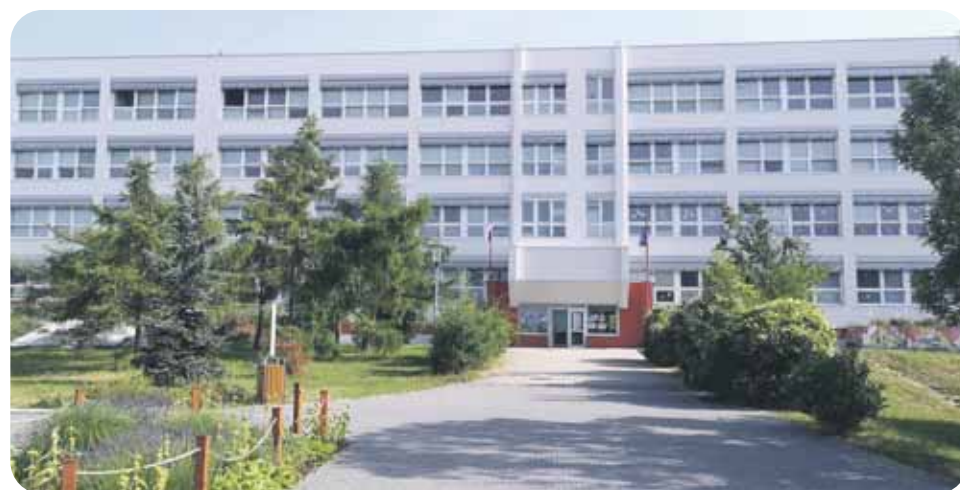
Zrekonštruovaná budova ZŠ na Majerníkovej ulici.
