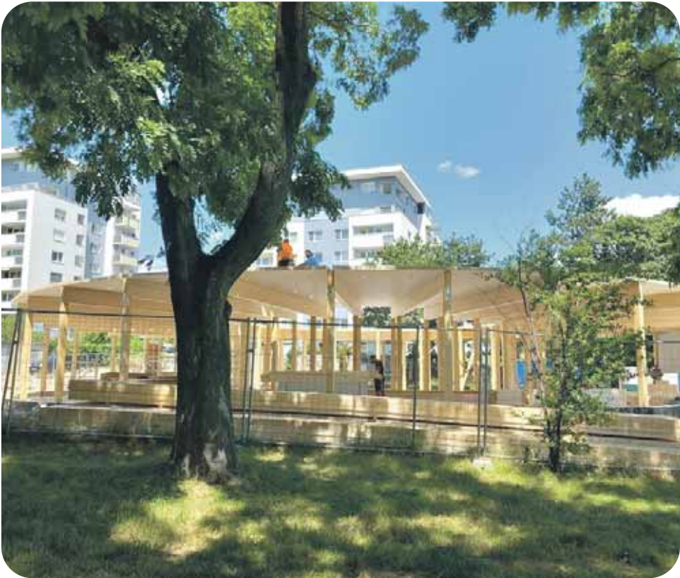
Výstavba MŠ Kadnárova
