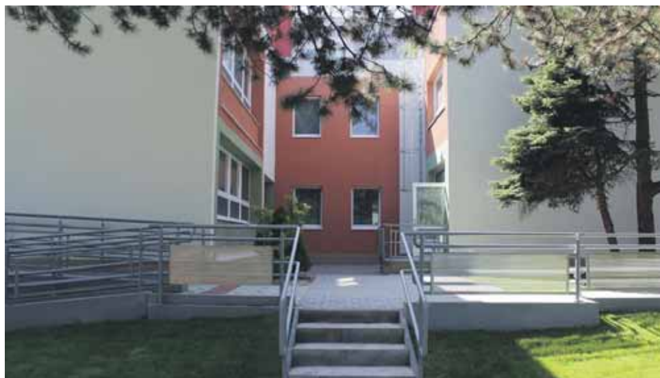
Rekonštrukciou MŠ na Fedákovej v Dúbravke vzniklo 92 nových miest
