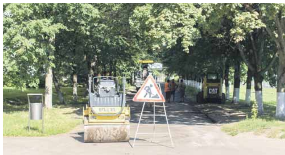
Rekonštrukcia Včelárskej ulice 2019
