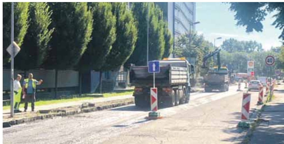
Oprava Drieňovej ulice 2020.
