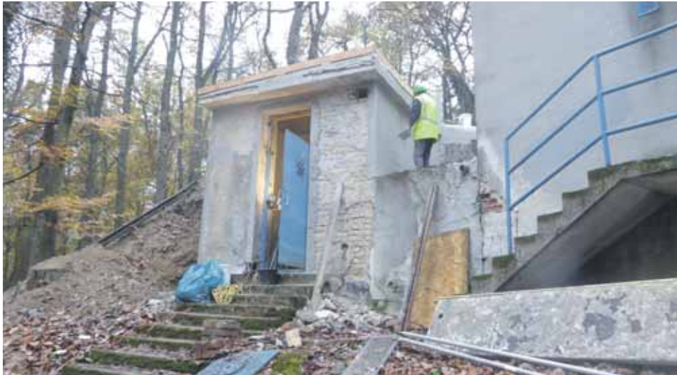
Rekonštrukcia vodojemu Koliba v Bratislave.
